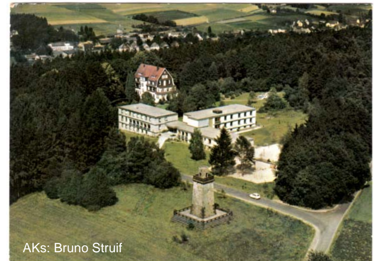
Luftbildaufnahme vom Bismarckturm in Altenkirchen
