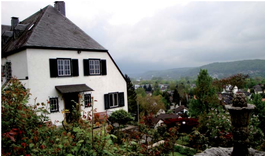
Nordseite des Konrad Adenauer-Hauses in Rhöndorf, vom Arbeitspavillon aus gesehen
